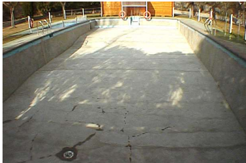
Antes del tratamiento
